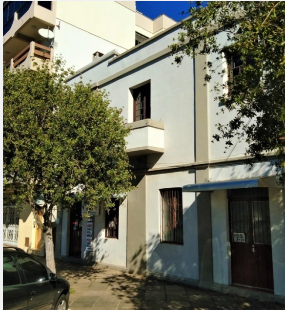
Aspecto da fachada frontal leste (Foto Henrique Zuchetto, 2020)
