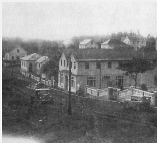
Aspecto da obra original, como sede da fábrica de erva-mate (DAL PAI; TOMASETTO, 1998)
