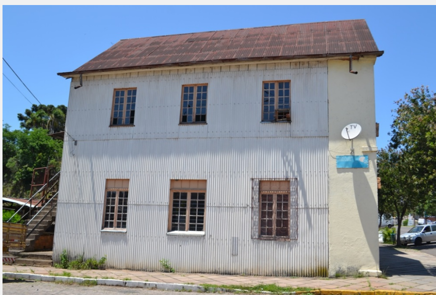
Detalhe da fachada oeste com acabamento de chapa ondulada (Foto Helton Estivalet Bello, 2019)
