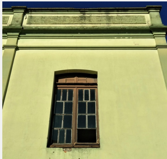
Detalhe da fachada lateral norte da Casa (Foto Henrique Zuchetto, 2020)
