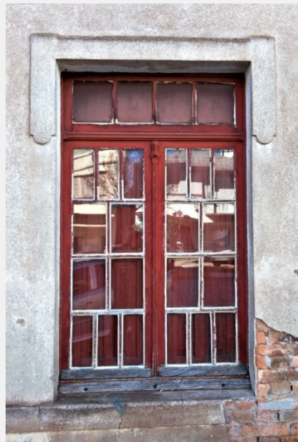
Detalhe esquadria na fachada frontal oeste (Foto Henrique Zuchetto, 2020)
