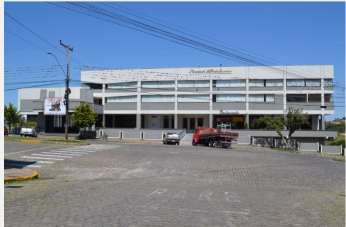
Vista da obra pela rua Carlos Barbosa (Foto Helton Estivalet Bello, 2019)
