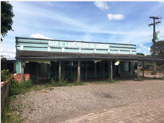
Fachada para a Avenida, encoberta por telheiro
