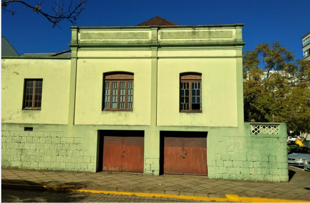
Aspecto da fachada lateral norte da Casa (Foto Henrique Zuchetto, 2020)
