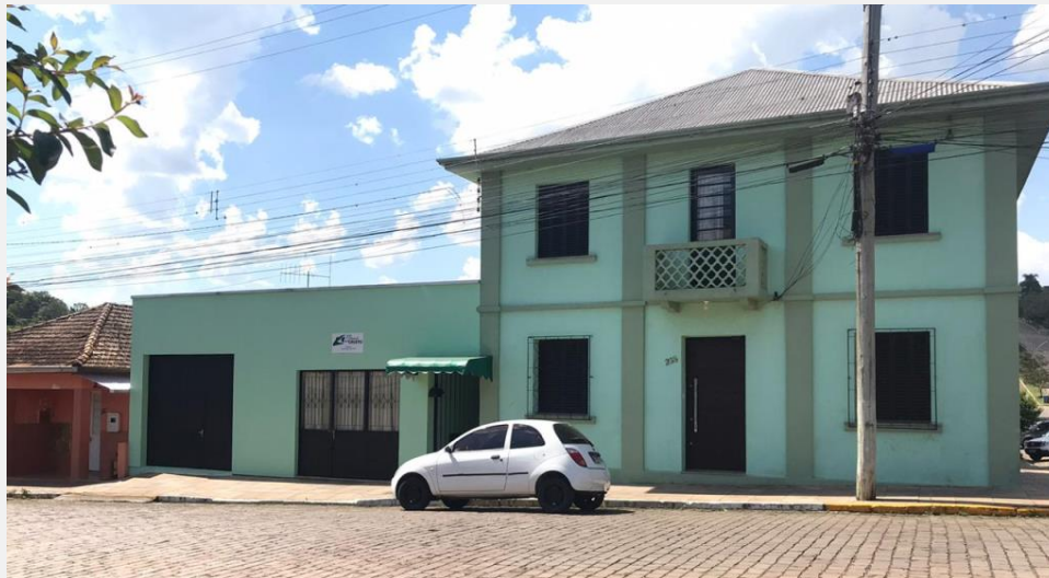
Aspecto da fachada lateral frontal norte com o acréscimo térreo (Foto Juliana Siqueira, 2019)
