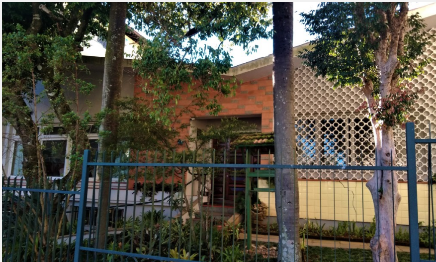
Detalhe do jardim e elementos da fachada frontal oeste (Foto Henrique Zuchetto, 2020)
