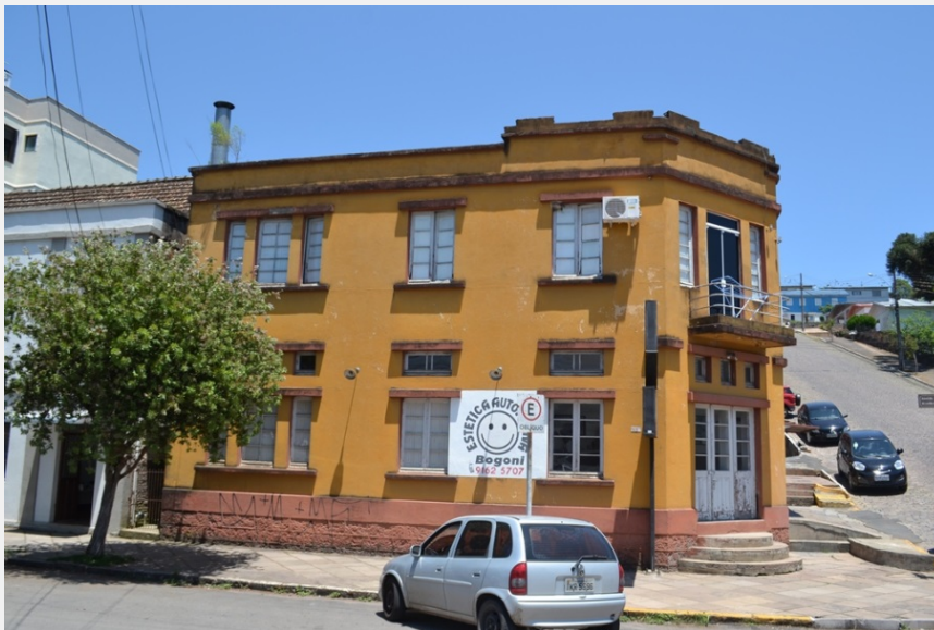
Vista da fachada leste (Foto Helton Estivalet Bello, 2019)
