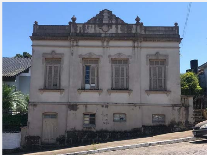
Aspecto da fachada frontal sul da Casa (Foto Juliana Siqueira, 2019)
