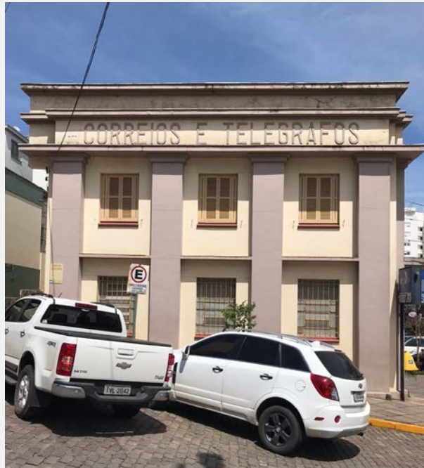
Agência ECT Veranópolis, fachada lateral leste (Foto de Juliana Siqueira, 2019)
