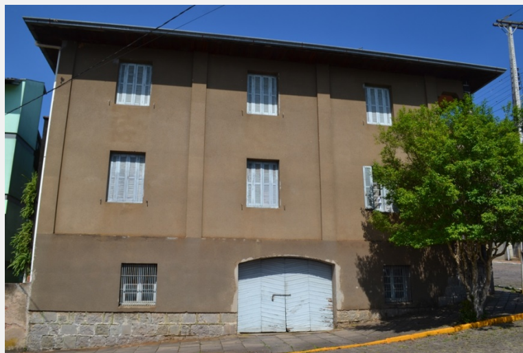
Aspecto da fachada lateral oeste (Foto Helton Estivalet Bello, 2019)
