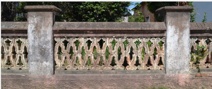
Detalhe do muro frontal com o padrão de elementos vazados cerâmicos (Foto Helton Estivalet Bello, 2019)
