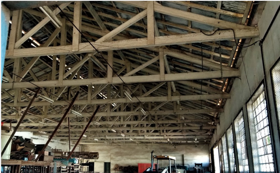
Aspecto interno, com destaque para a estrutura do telhado (Foto Henrique Zuchetto, 2020)
