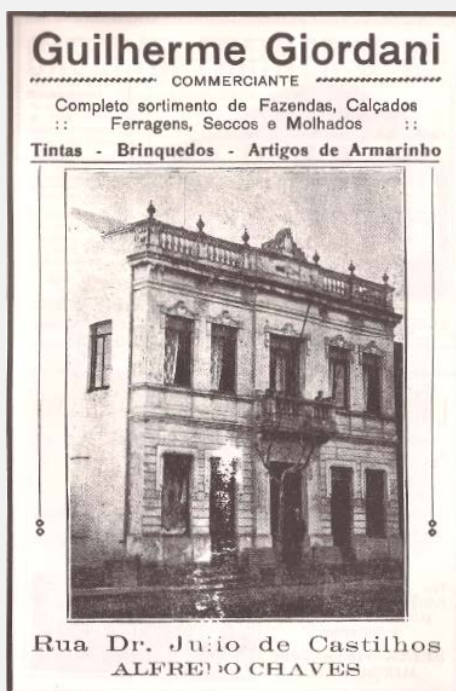
Imagem da Casa em anúncio comercial (PIMENTEL, apud. COMARÚ, 2011)
