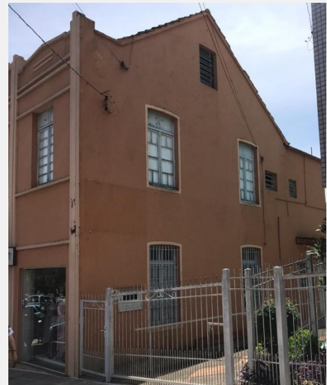
Vista da empena lateral da edificação (Foto de Helton Estivalet Bello, 2019)
