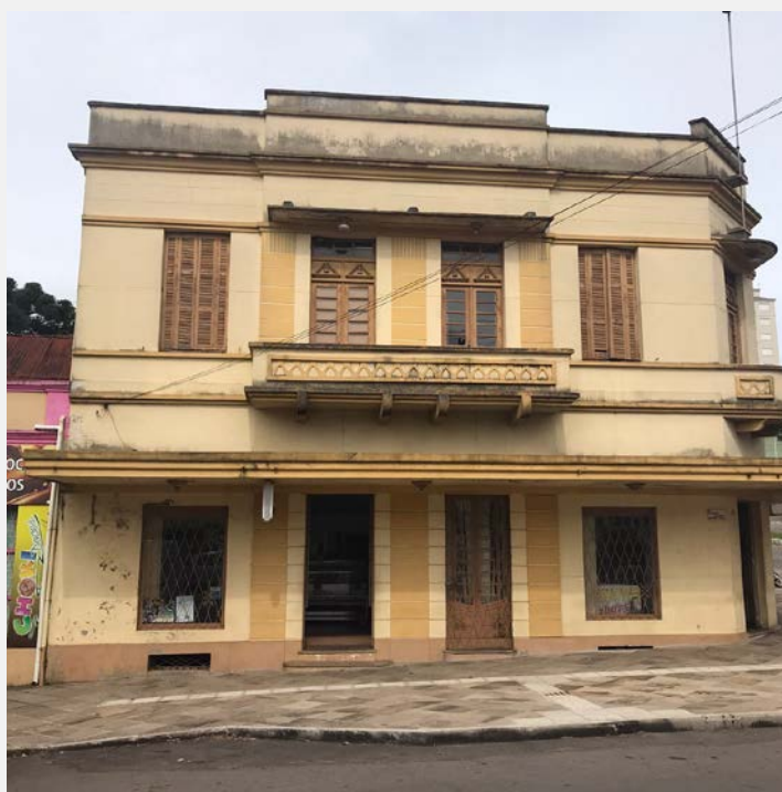
Detalhe da composição da fachada oeste (Foto Juliana Siqueira, 2019)
