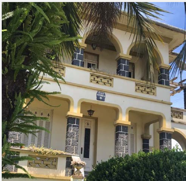
Detalhe de elementos da fachada frontal norte (Foto Juliana Siqueira, 2019)
