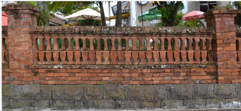
Detalhe dos elementos cerâmicos no muro sobre os alinhamentos da esquina (Foto Helton Estivalet Bello, 2019)
