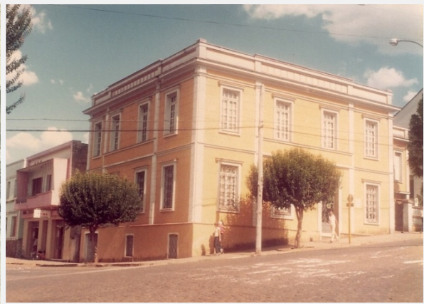
Aspecto da Casa ampliada, em 1982 ( https://sites.google.com/site/veranopolisrs )
