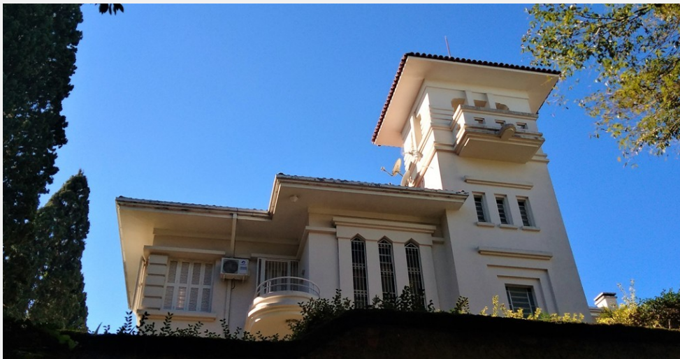
Aspecto da fachada lateral oeste do Palacete (Foto Henrique Zuchetto, 2020)
