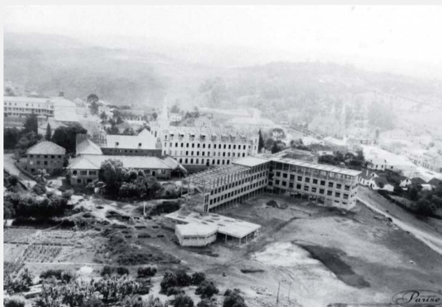
Vista da obra de ampliação na Década de 1960 (Acervo Elígio Parise, apud O Estafeta, 2019)
