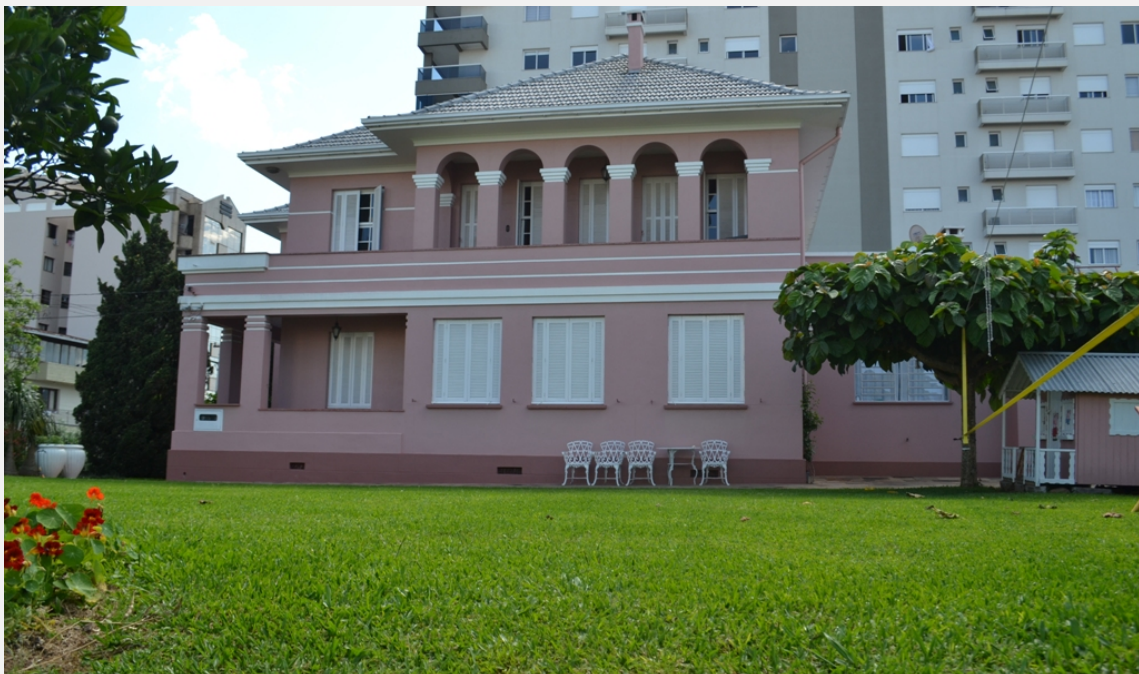
Vista do jardim lateral e fachada leste do Palacete (Foto Helton Estivalet Bello, 2019)
