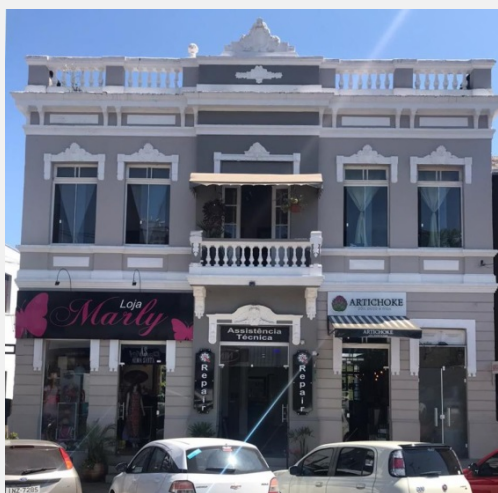
Fachada frontal sul (Foto Helton Estivalet Bello, 2019)
