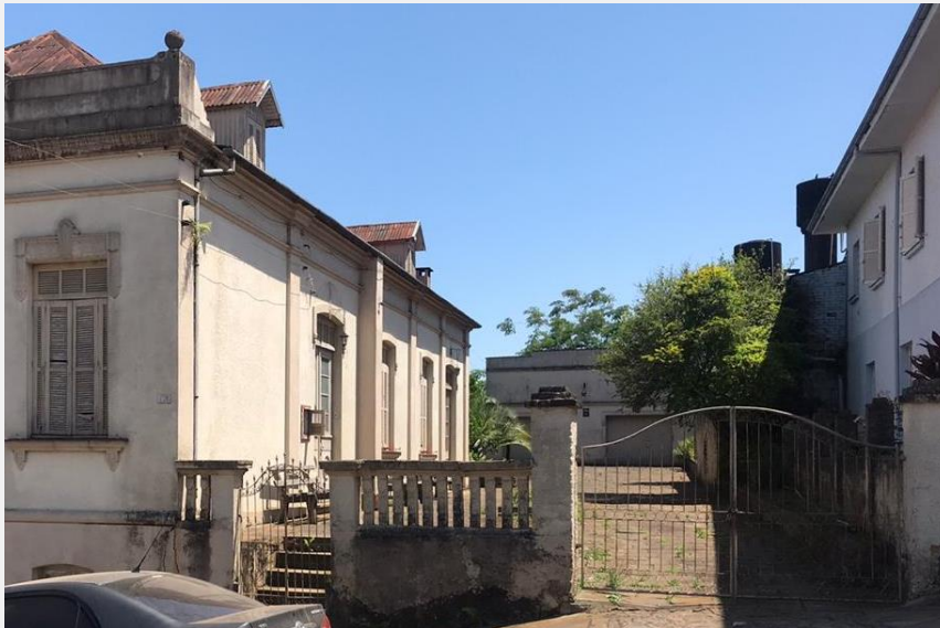
Acesso e fachada sobre o recuo lateral, incluindo as mansardas hoje inexistentes (Foto Juliana Siqueira, 2019)
