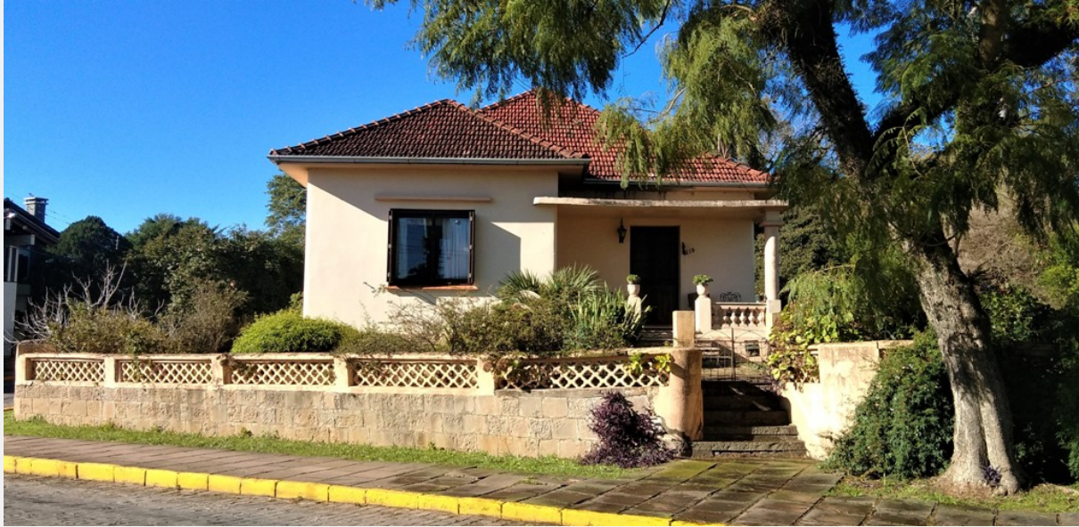
Vista da fachada e muro frontal (Foto Henrique Zuchetto, 2020)
