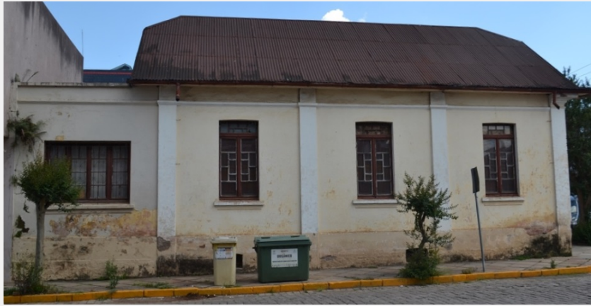
Aspecto da fachada lateral norte da Casa (Foto Helton Estivalet Bello, 2019)
