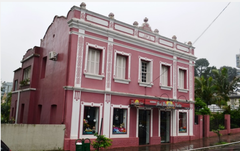
Aspecto do tratamento contrastante entre as fachadas frontal e lateral (Foto Helton Estivalet Bello, 2019)
