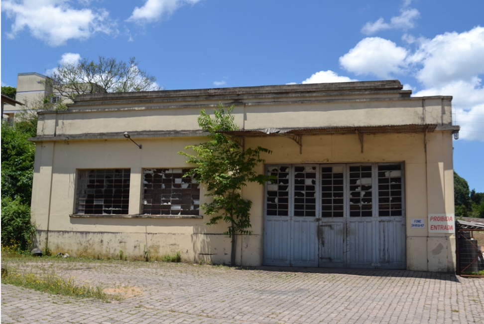
Detalhe da fachada frontal oeste (Foto Helton Estivalet Bello, 2019)
