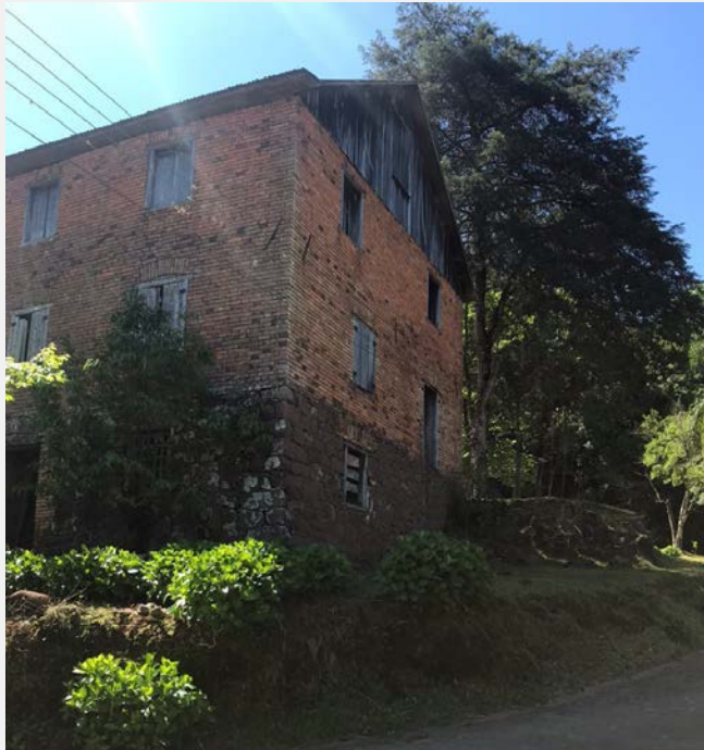
Vista da lateral leste com a empena da cobertura em madeira (Foto Henrique Zuchetto, 2019)
