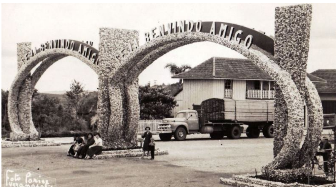
Figura 8 - Arcos de acesso finalizados, com a Casa Saretta ao fundo (Acervo Elígio Parise, apud. COMARÚ, 2011)
