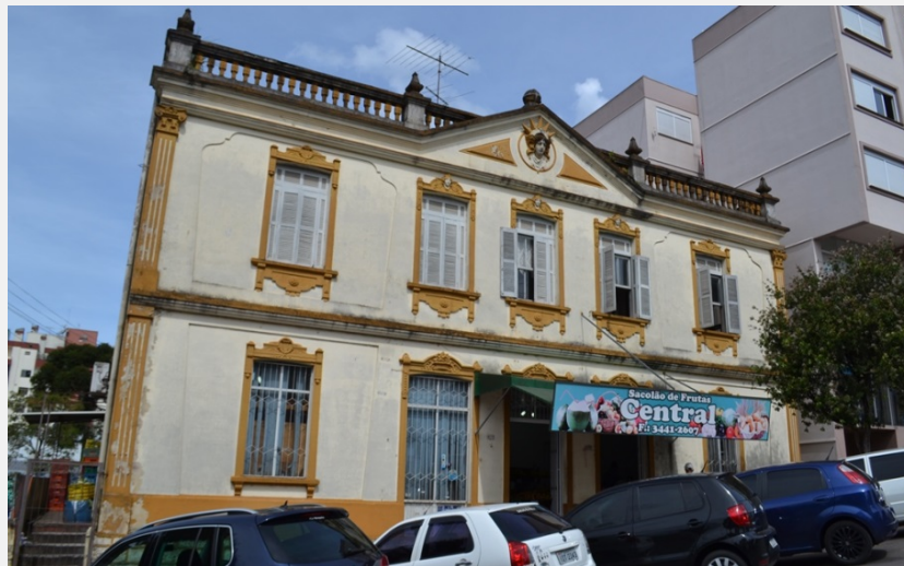
Fachada frontal oeste da Casa Farina-Munaretti (Foto Helton Estivalet Bello, 2019)
