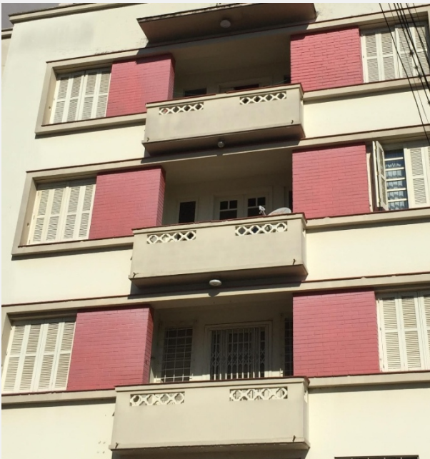
Detalhe da fachada norte (Foto Bruno Eder Giasson, 2019)
