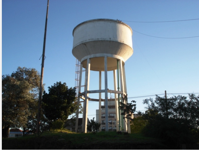
Reservatório do Depto. Municipal de Água e Esgotos (DMAE), Porto Alegre, de 1950 (Foto: Helton Estivalet Bello, 2007)
