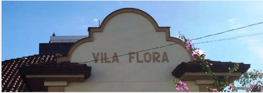
Detalhe do frontão e beirais fachada principal sul (Foto Bruno Eder Giasson, 2019)
