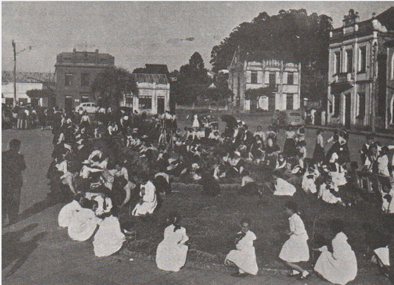
A obra ao fundo (centro-direita), vista como cenário da Praça Central (FARINA, 1992)
