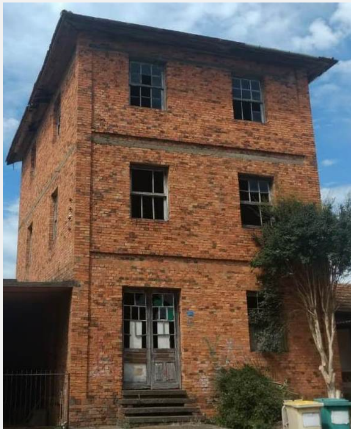
Fachadas norte e leste em detalhe (Foto Helton Estivalet Bello, 2019)
